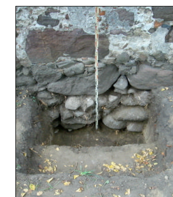
Schürfgrube am Fundament
